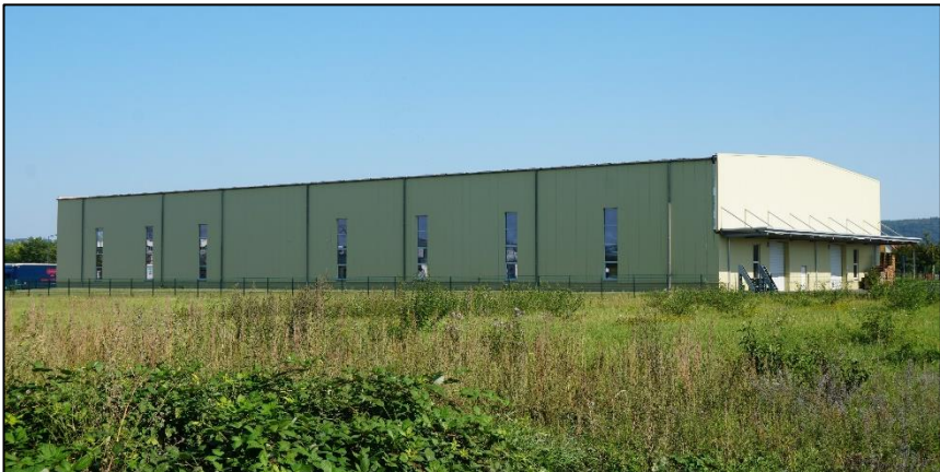
Abbildung 2: Produktions- und Lagerhalle in der Industrie (Quelle: Uhlig)
