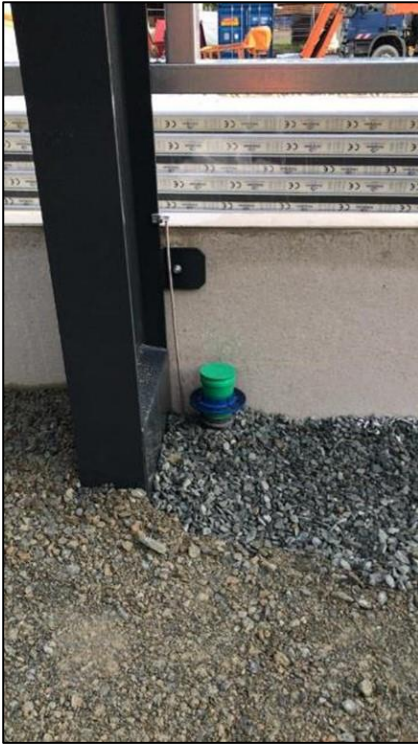
Abb. 15 und 16: Steigrohr der Dranage neben dem Stutzenfu
