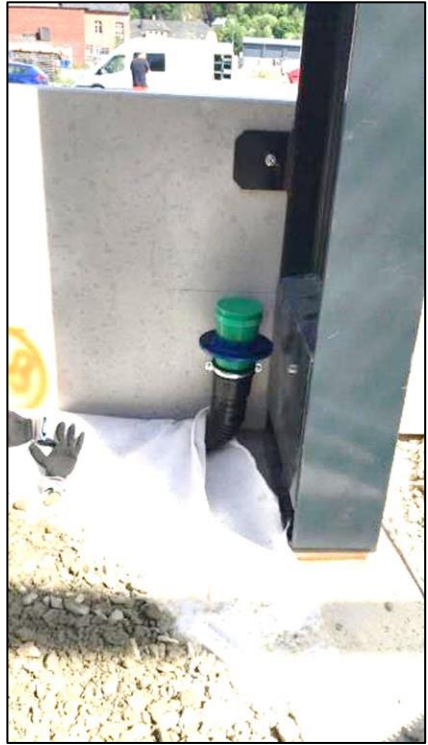
Abb. 15 und 16: Steigrohr der Dranage neben dem Stutzenfu
