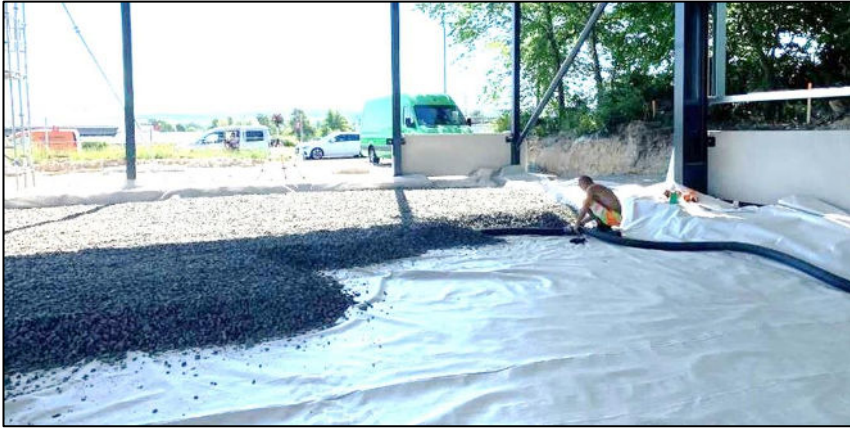
Abbildung 14: Einbau der Dränageschicht (Quelle: List Bau München)
