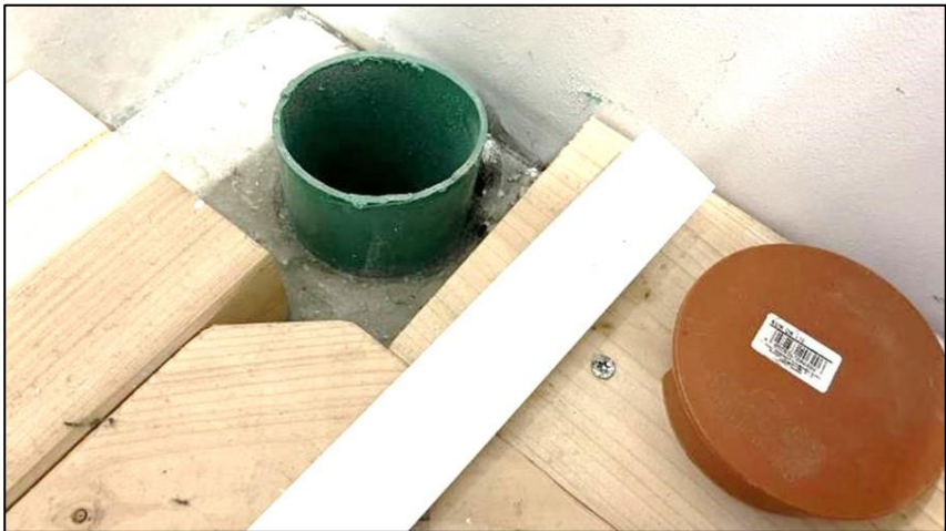
Abb. 17: Abschlusdeckel des Steigrohres; Die Holzbohlen dienen dem Schutz der Steigrohre wahrend der Bauphase
